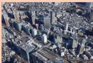
再開発の進む大崎駅周辺
